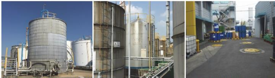
[고정지붕형 저장시설 예시(CRT, Cone Roof Tank)]
