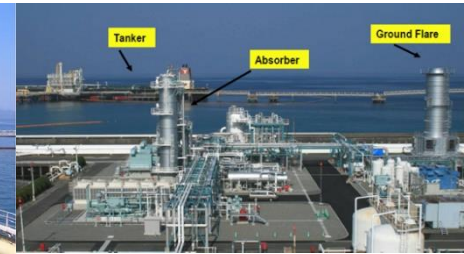
<선박에서 원유 하역 과정에서의 VOCs 흡수·회수 및 고온 산화 처리>
